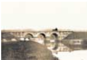
Den nyanlagda Boråsbanan breder ut sig i första delen av Jan Lindqvists film om åren 1859-1879. Här byggs dåtidens, det kommande industrisamhällets, monumentala kommunikationsnät.
